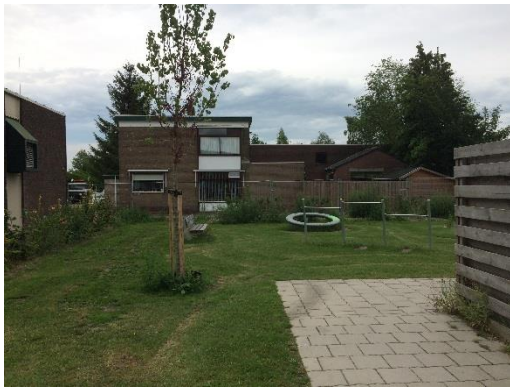
Foto 6 aanwezige gebouw met opstallen, mogelijk geschikt voor vleermuizen.
